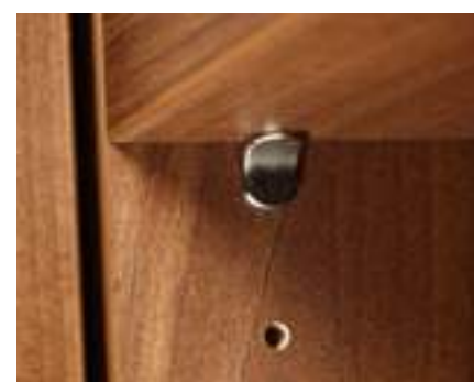
Podpěrka police se zajištěním proti nechtěnému vysunutí
