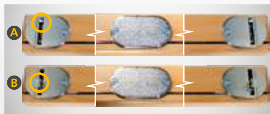
Dvoubodový zámek se zafrézovanými táhly
